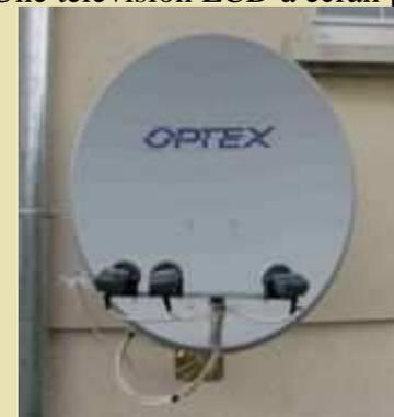
Antenne satellite à trois têtes : trois positions orbitales différentes, Atlantic Bird à 5°Ouest, Hot-Bird à 13° Est et Astra à 19° Est.
